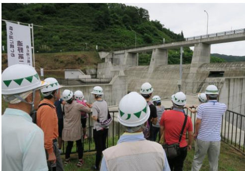
ダム施設見学
