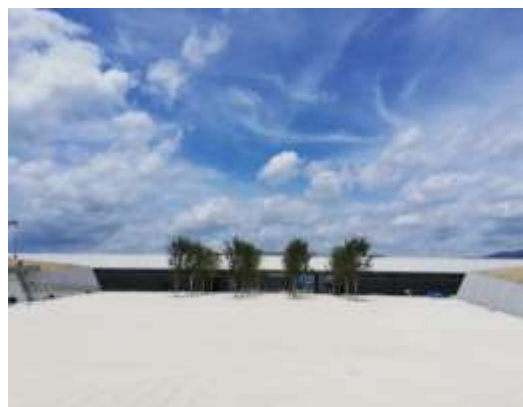
「東日本大震災津波伝承館」を含む国営追悼・祈念施設全景
