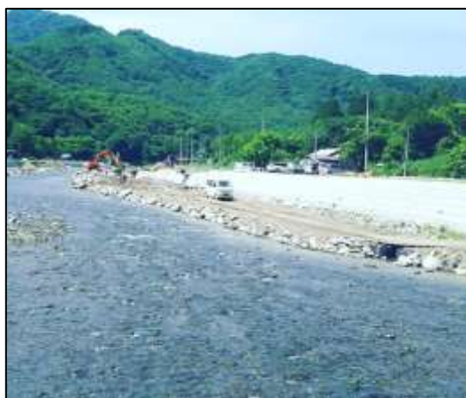
岩泉町安家川河川改修工事
