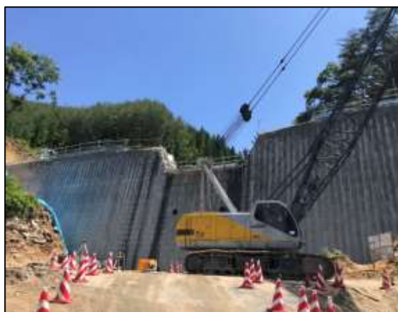
岩泉町上乙茂の沢砂防工事
