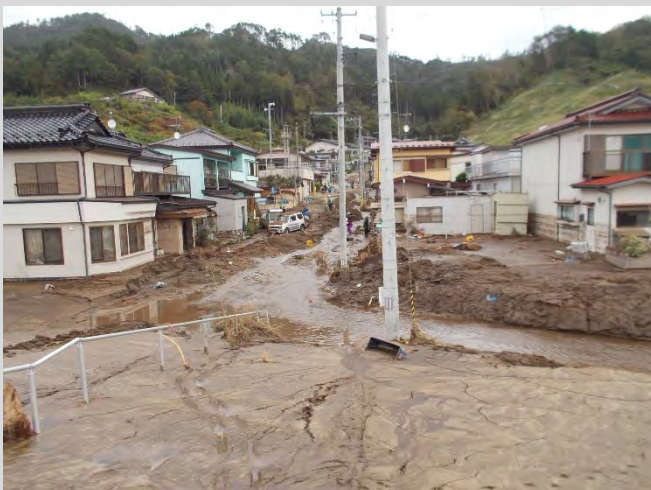
令和元年東日本台風の被害状況(令和元年10月)
