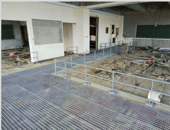
立入防止柵により見学者の通路と安全を確保
