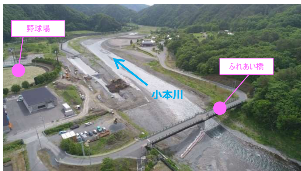
小本川の施工状況 (R元.5.31 乙茂地区)
