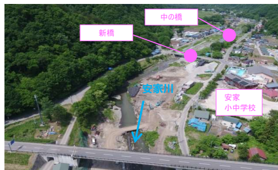
安家川の施工状況 (R元.6.5 松林地区)
