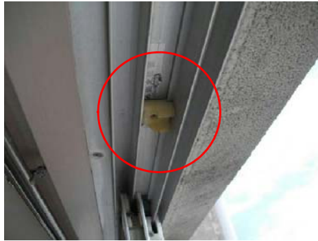
落下した障子のはまっていた 窓枠の外れ止め部品 (経年劣化が原因と考えられる欠損)
