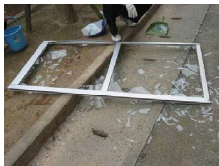
落下して破損した障子
