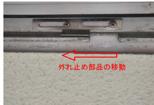
外れ止め部品（障子落下時）
