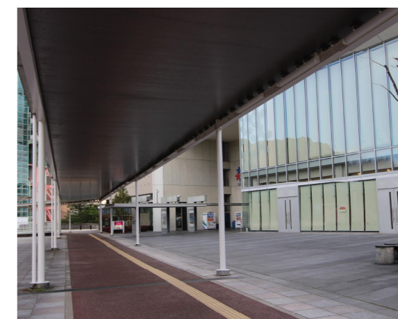
通路の上屋と誘導ブロックの設置 屋根付き通路と、舗装面との色の違いに配慮し、連続して敷設した視覚障がい者用誘導ブロック。
