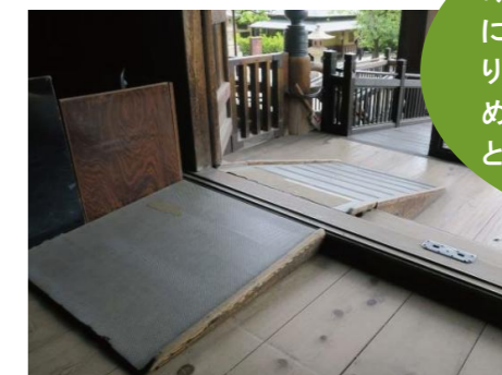
本堂入口のスロープ
