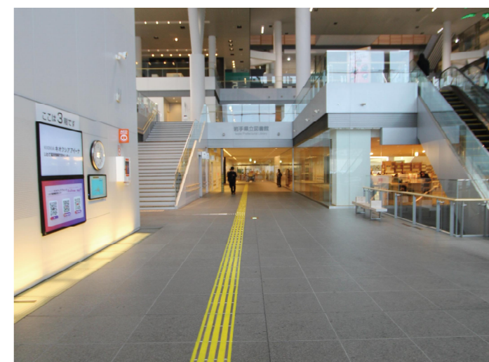
▲トイレやエレベーター、図書館出入口へ誘導する線状ブロック
