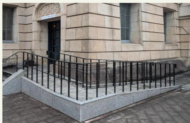
出入口（築地本願寺本堂）の傾斜路
