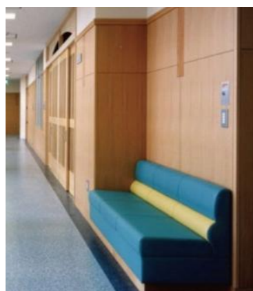
廊下へのベンチの設置 廊下にはみ出さないように設置。
