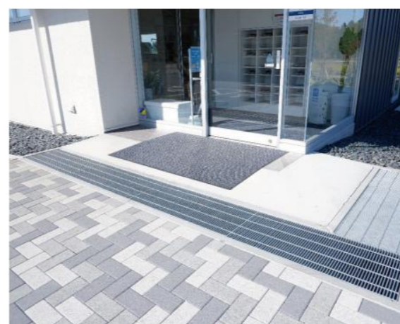
車いすのキャスターや杖が溝に落ちない配慮 段差がなく、隙間が細かい蓋を使った排水溝。
