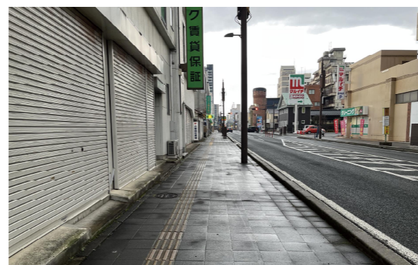
必要な幅員を確保する。 視覚障がい者用誘導ブロックの設置。
