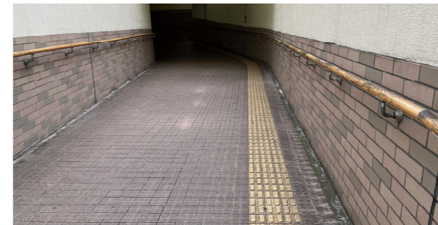
視覚障がい者用誘導ブロックの設置。
