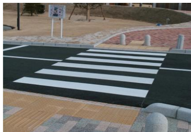
▲歩道と道路の境界に設置した警告を促す点状ブロック
