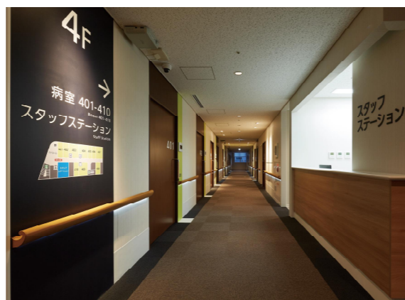
ゆとりある通路と連続した手すり 車いすの人同士がすれ違うことができる幅員が確保されている。
