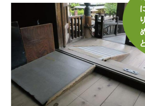
本堂入口のスロープ
