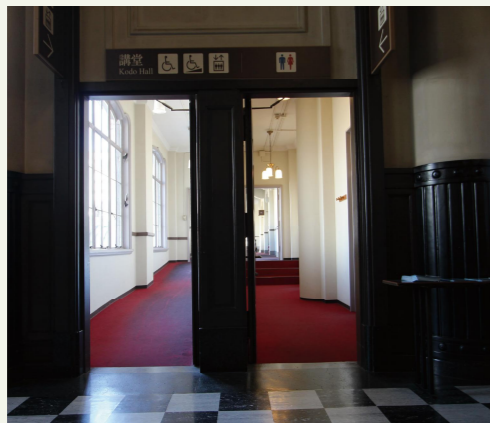
段に併設された傾斜路 主要な経路の階段に併設された傾斜路。
