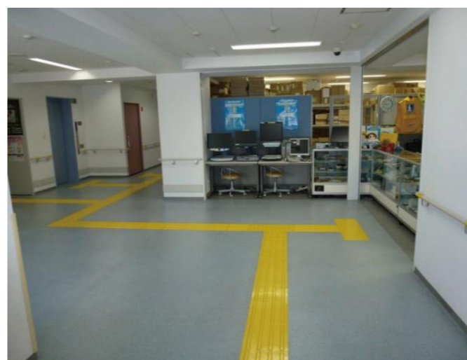
▲受付やエレベーターへ誘導する線状ブロック
