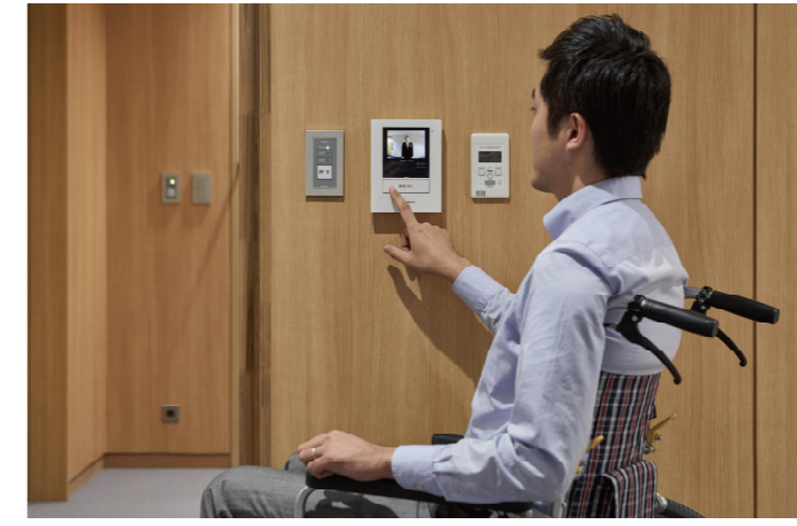
▲スイッチやドアモニターは、床から110cmの高さに統一し、解錠ボタン・ドアモニター・空調スイッチをまとめて配置する。
