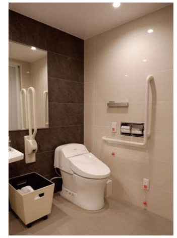
▲車いすが転回できるスペースを確保し、L型と跳ね上げ式の手すりを設置している。
