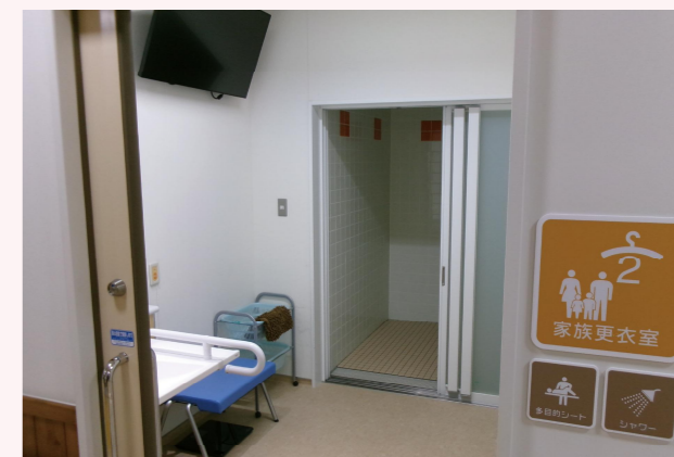
家族更衣室に設置したシャワー室
