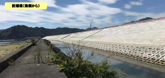
防潮堤(海側から)
