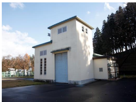
胆沢第二発電所
