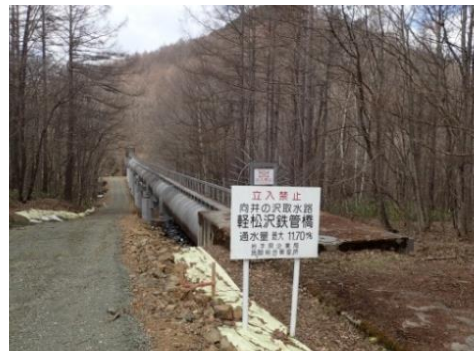
軽松沢鉄管橋
