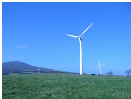
稲庭高原風力発電所（既設）
