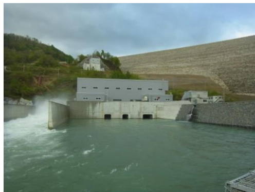
胆沢第三発電所
