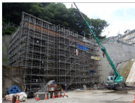
建設中の築川発電所
