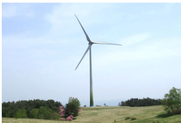
高森高原風力発電所
