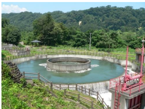
胆沢第二発電所下流の円筒分水（徳水園）
