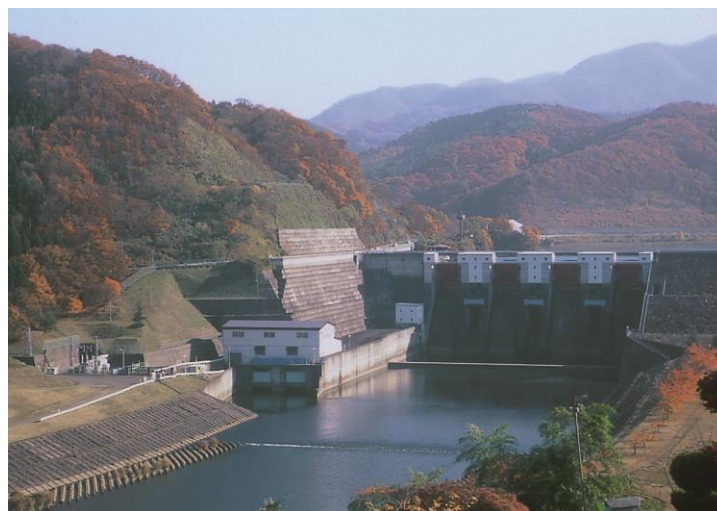
御所ダムと御所発電所
