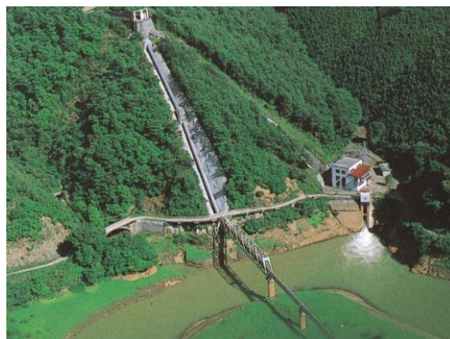
岩洞第二発電所
