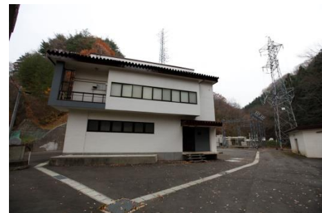
岩洞第二発電所建屋
