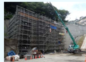
建設中の築川発電所
