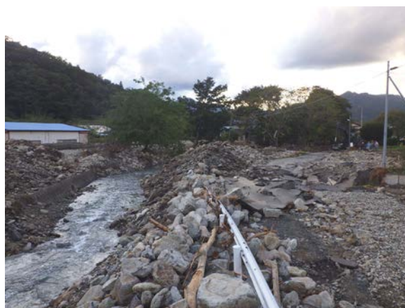
<山田町 準用河川長内川 堆積土砂撤去後>
