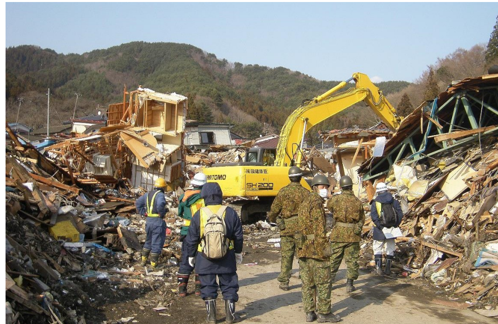
けいかい 大槌町安渡小学校へ向かう道路の啓開作業
