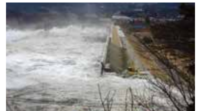
津波が工事区間を越流(午後3時34分)
