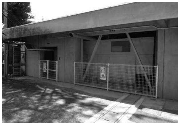
奥州地区合同庁舎非常用発電設備新設(平成24(2012)年度整備完了)
