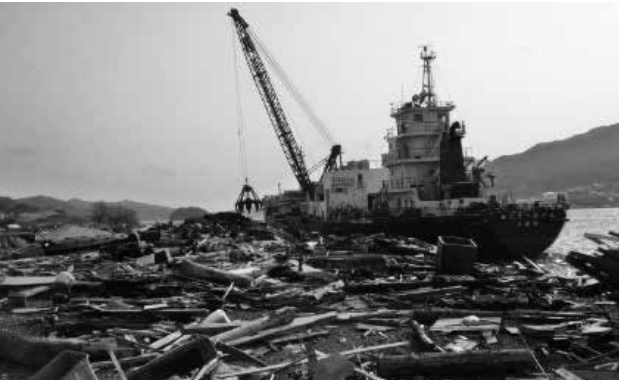
大船渡港での海上啓開作業
