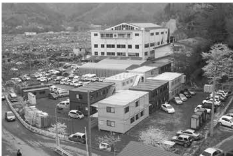
【大槌町】 仮庁舎を大槌小学校校庭に設置(H23.5から利用)
