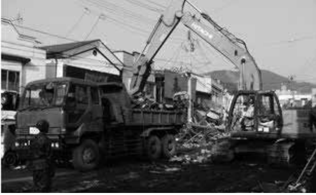
釜石市での道路啓開作業(H23(2011).3.13)
