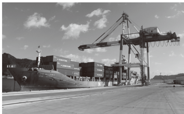
ガントリークレーンによるコンテナ荷役 H29.11.17 釜石港
