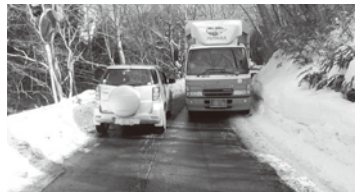
現道の様子(すれ違いが困難で幅員狭小区間が連続(最小幅員3.3m))
