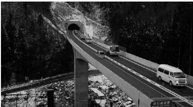
平成23年3月5日に開通した釜石山田道路
