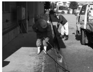
側溝清掃及び高圧洗浄作業
