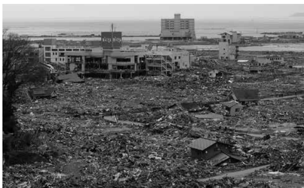
津波により多くの建物が倒壊した（陸前高田市）
