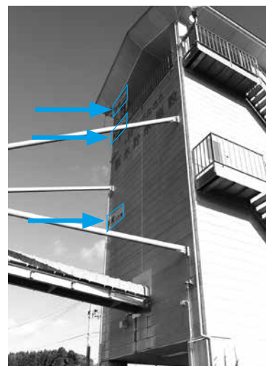
宮古市田老での津波痕跡表示(明治、昭和、平成)
