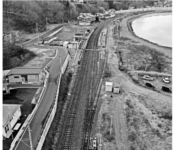
震災後に整備された防潮堤と八木地区の宅地嵩上げ
