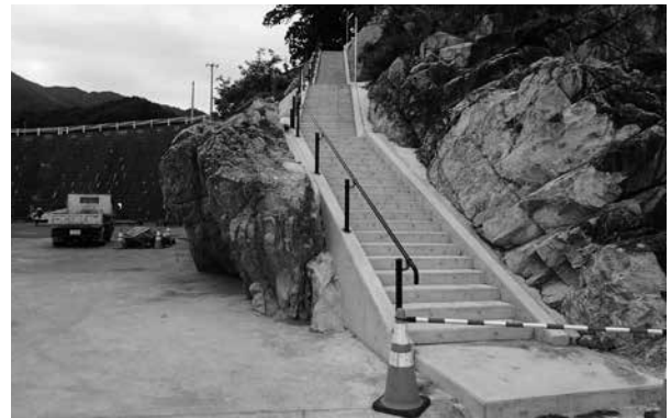
津波避難路(重茂石浜地区)
