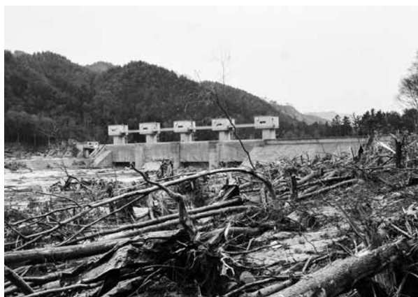
被災直後の普代水門
