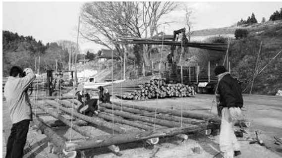
供給されたスギ丸太を使用した養殖筏の組立作業
