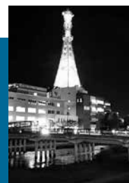
ライトアップした無線鉄塔
