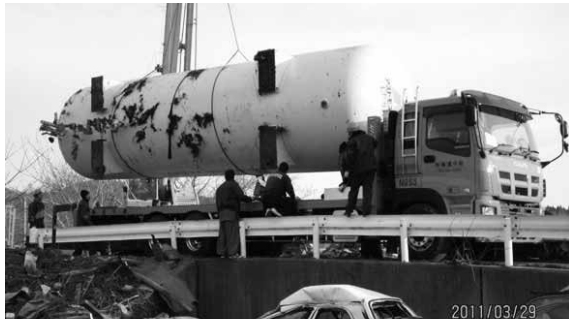
津波で流出した20tLPガスタンクを回収(宮古市内)
