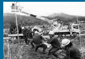
震災後、通信の早期復旧に向けた活動の様子
