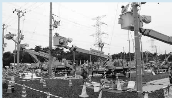
災害発生時の対応力向上を目指す復旧作業の訓練
