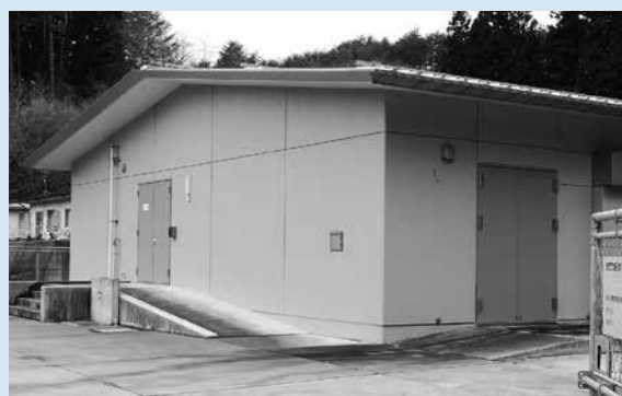
津波対策に高台にて移設した通信ビル
