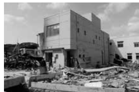
被災翌週の山田支店の状況
