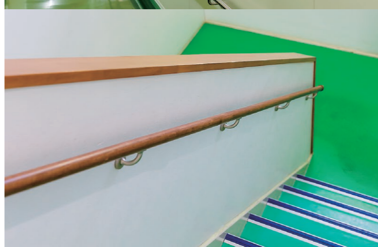
廊下や階段に手すりを設置したことで、安全面が向上した
