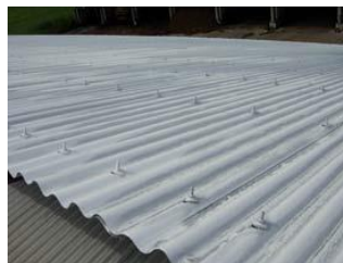
畜舎屋根 への石灰 塗布
