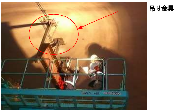
写真-解6.3 触診作業状況
