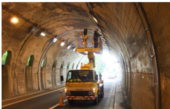
写真-解6.1 近接目視作業状況
