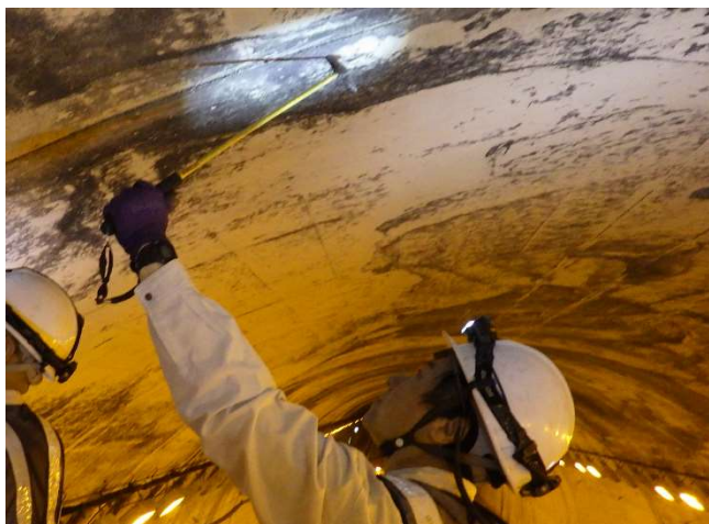
(a)トンネル本体工
