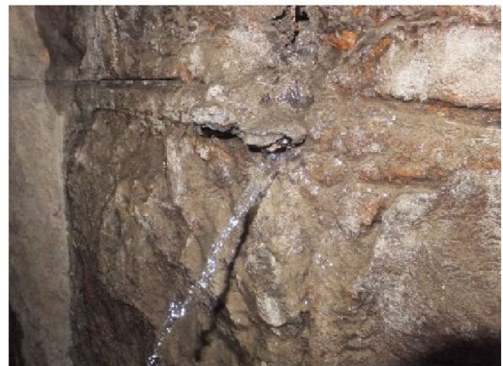
付写真-1.7 漏水（噴出）している例
