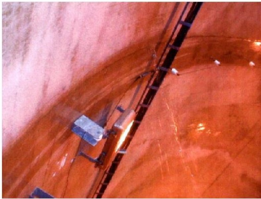
付写真-1.7 漏水（噴出）している例
