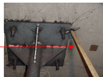
打音検査の例
