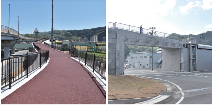
供用が開始されたグリーンベルト
