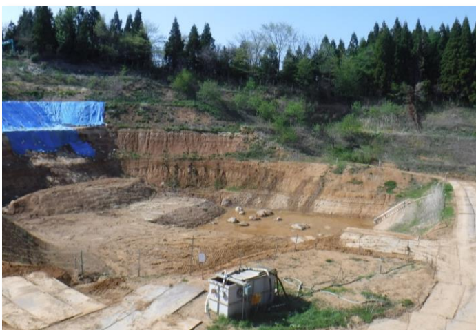
写真 3-3 掘削前の状況 （令和元年5月13日撮影）
