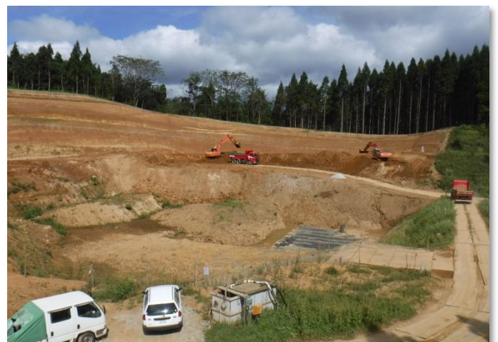
写真 3-4 掘削状況 （令和元年9月6日撮影）
