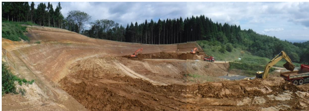
写真 3-2 B地区北側法面の掘削状況（令和元年9月6日撮影）
