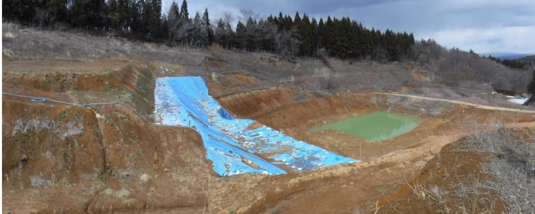
写真 3-1 B地区北側法面の掘削状況（平成31年4月11日撮影）
