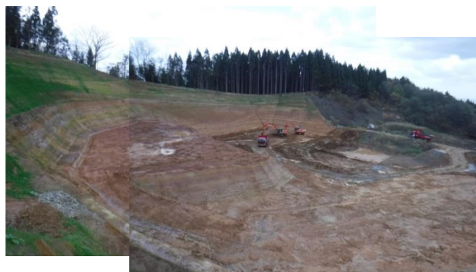
写真2-2 B地区北側法面の掘削完了状況 (令和元年10月30日撮影)
