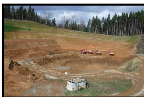
写真2-4 掘削完了状況(令和元年10月30日撮影)
