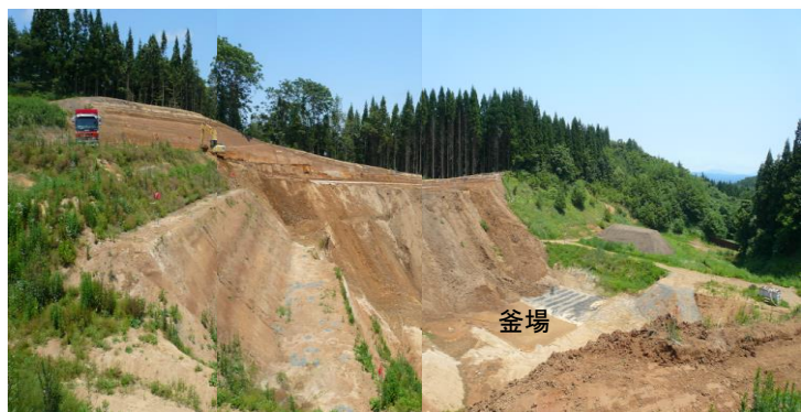
写真2-1 B地区北側法面の掘削状況 (令和元年7月10日撮影)
