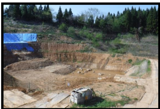
写真2-3 掘削前の状況(令和元年5月13日撮影)
