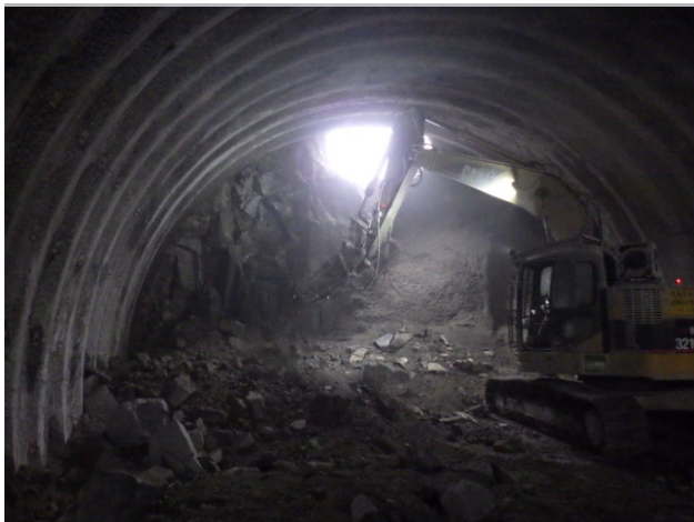
(仮称) 渋民トンネル貫通(一関市)
