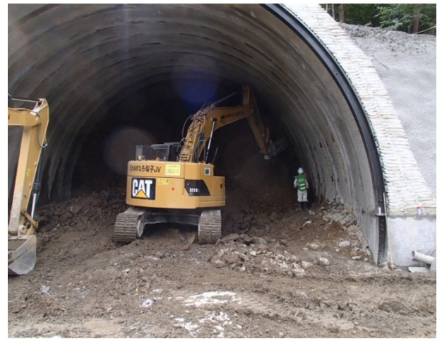
久慈側坑口の掘削状況(R1.7.19)
