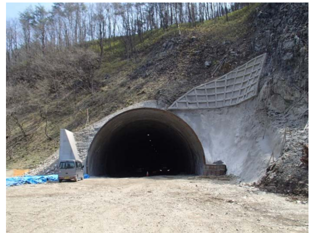
(仮称) 下川井トンネル貫通後
