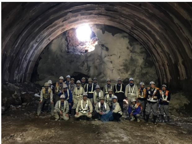
貫通直後の状況(R2.4.3)
