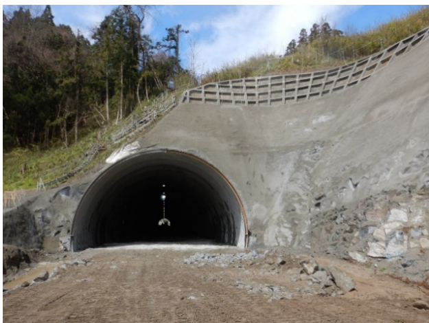
(仮称) 渋民トンネル貫通後
