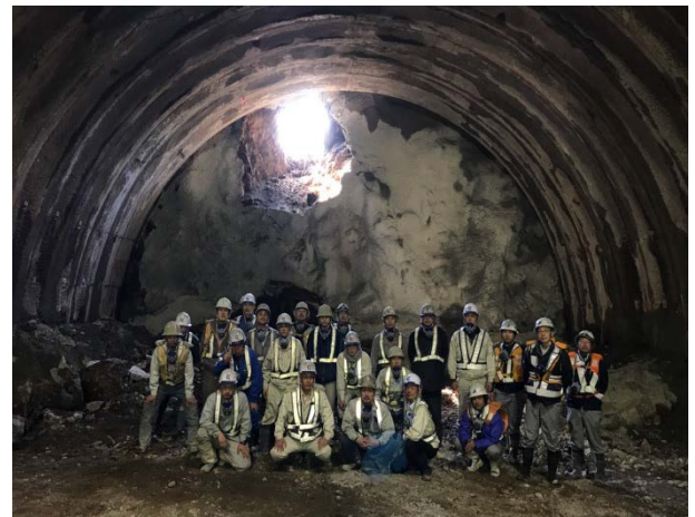
(仮称) 下川井トンネル貫通(久慈市)
