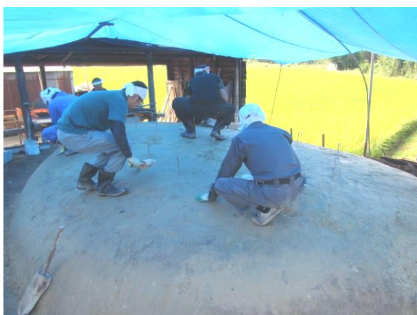
製炭技士養成研修会（築窯作業）の状況
