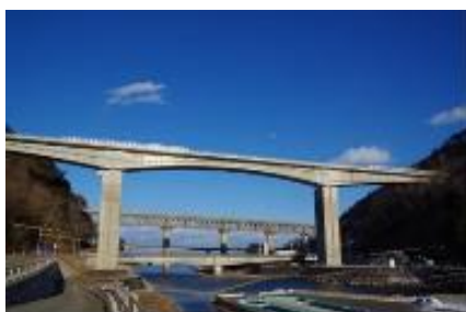
展示写真の例 (三沿道新安家橋梁付近)
