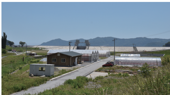
一部完成したイチゴ生産施設
