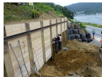
土木工事における木材利用 (矢板)
