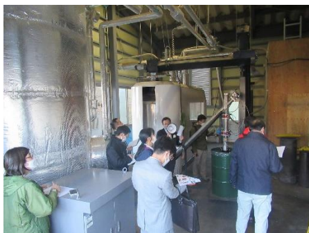
熱電併給システムに関する 現地研修会
