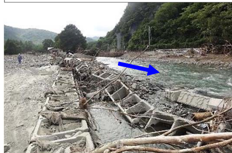
⑤右岸側の溢水被災状況
