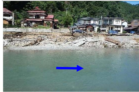
②左岸側の溢水被災状況
