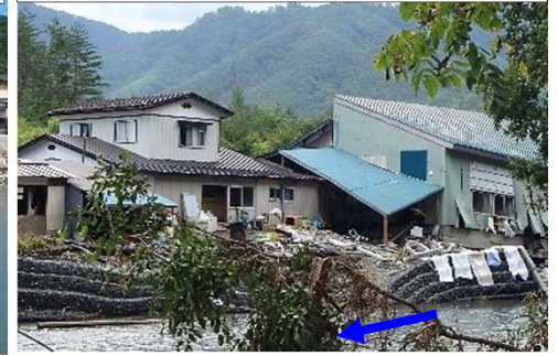
③右岸側の溢水被災状況
