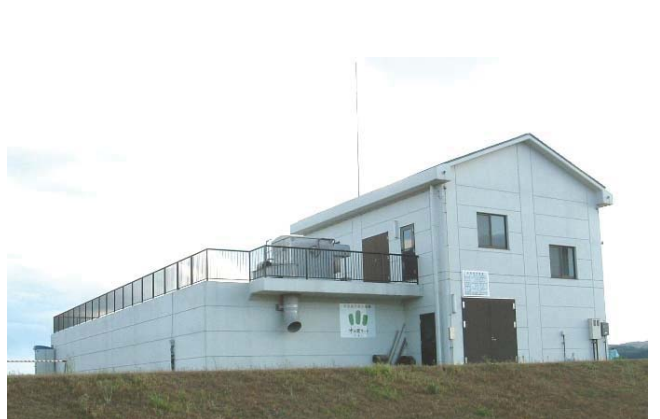
【平泉統合揚水機場】
