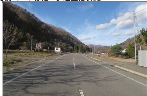
整備後（2車線化・歩道整備状況）
