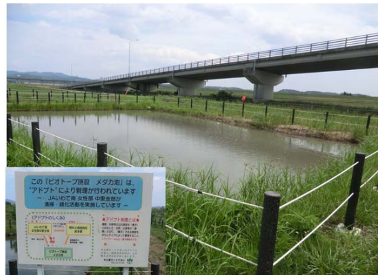
【ビオトープ施設】
