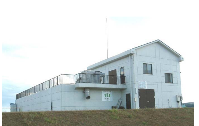
【平泉統合揚水機場】
