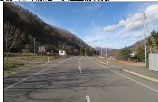
整備後（2車線化・歩道整備状況）
