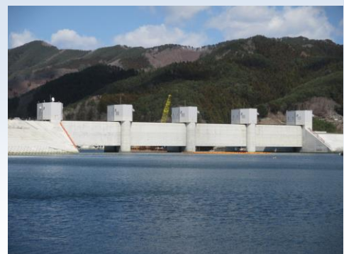
大槌川水門（令和2年2月完成）
