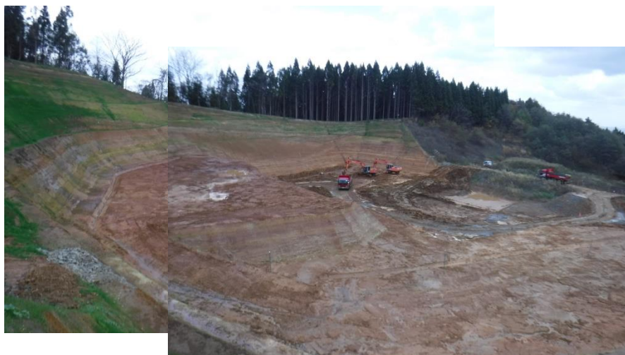
図4 B地区北側法面の掘削完了状況（令和元年10月30日撮影）
