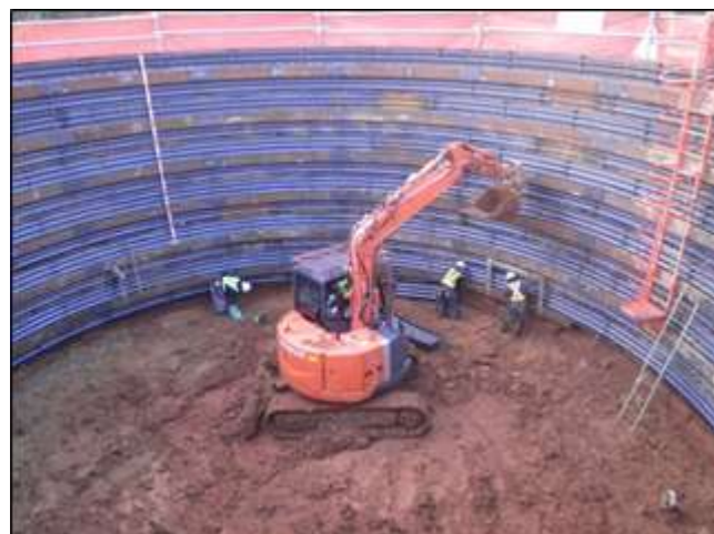
① ライナープレート（A地区西側、A-B地区境界部）
