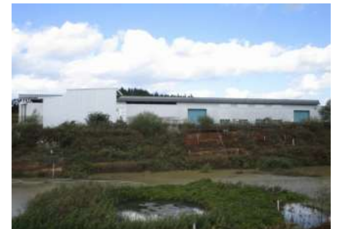
④ 水処理施設建屋。約40×75m
