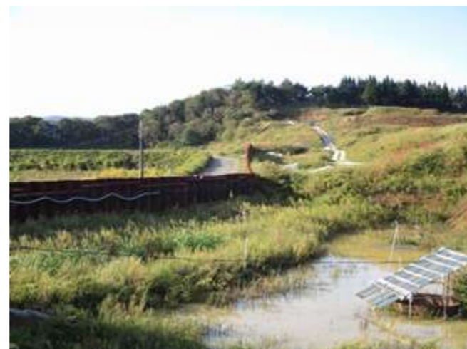
② 鋼矢板と凹地
