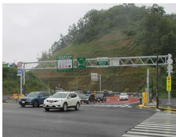
港湾に直結した宮古港IC (R2.7.12供用) (提供: 三陸国道事務所)
