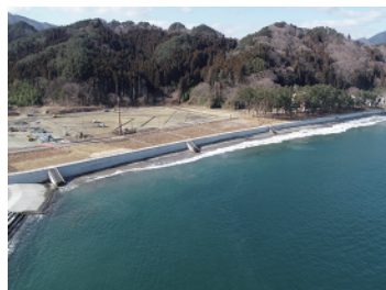
工事前の根浜海岸
