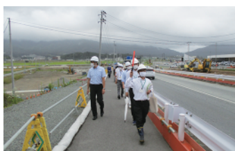
工事中の国道を歩いての避難
