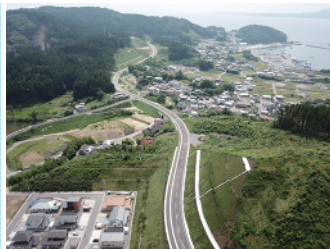
道路改良工事が完了した 久保～泊工区
