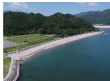
工事完了後の根浜海岸
