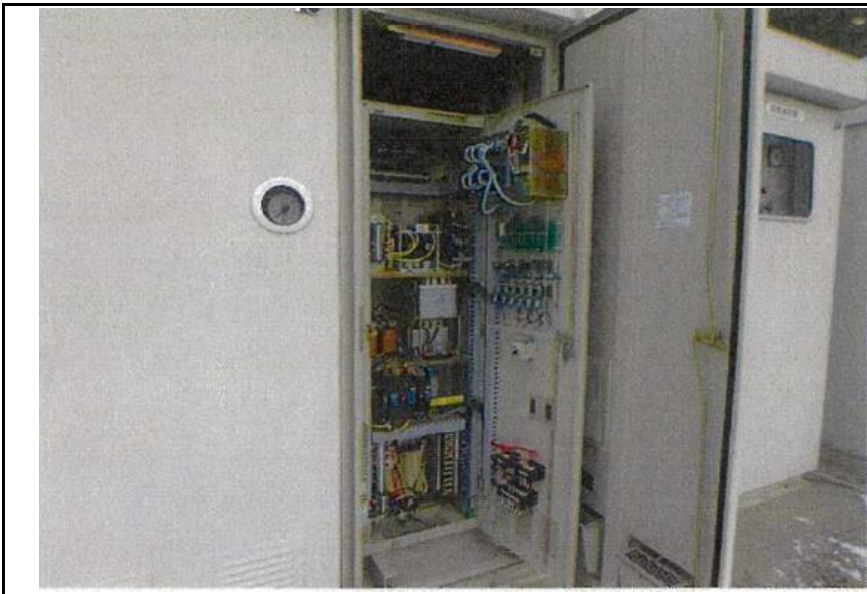
盤内部の電気設備の更新 及び必要な改造を実施。
