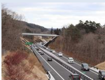
三陸沿岸道路 久慈北 IC～侍浜 IC R2.3.1 開通
