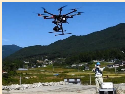
写真2：UAV (ドローン) による3次元測量
