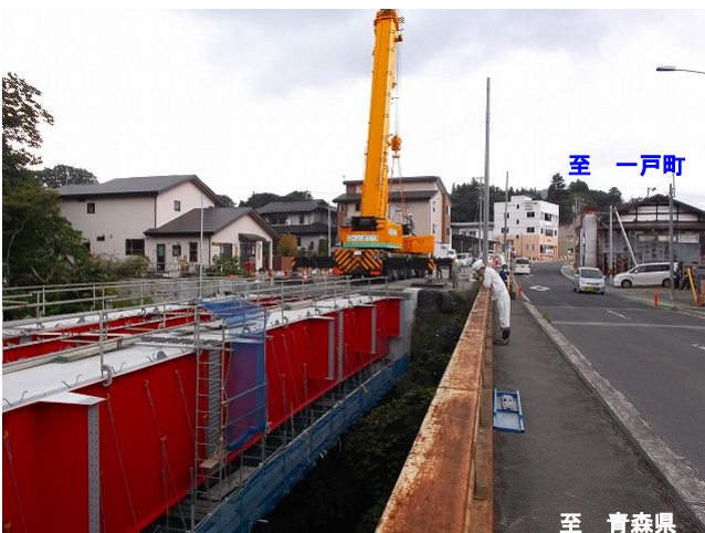
令和2年9月23日までの桁の架設状況(クレーン架設完了)
