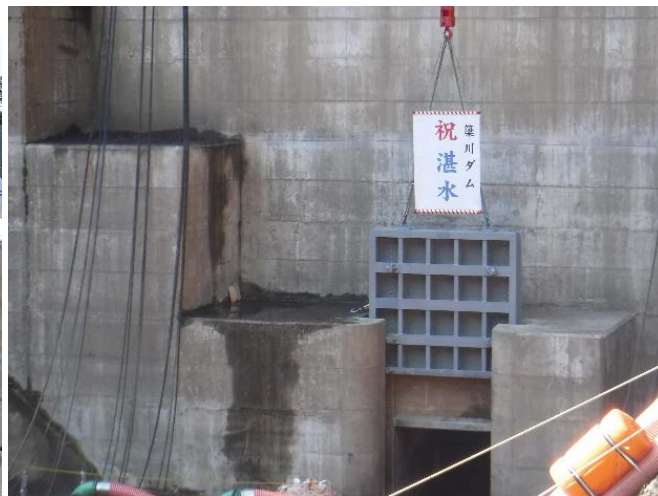
堤内仮排水路トンネルの閉塞ゲート
