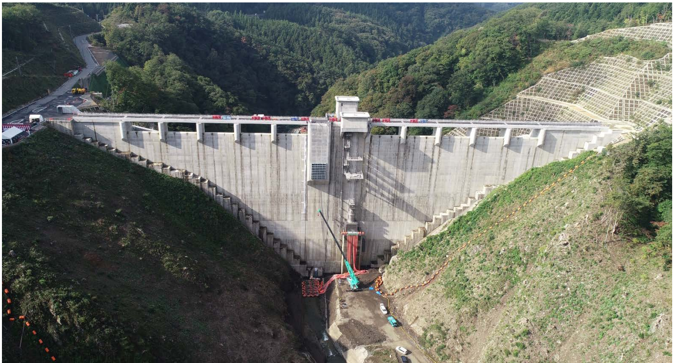
試験湛水開始直前のダムの状況（堤体上流側からドローンで撮影）
