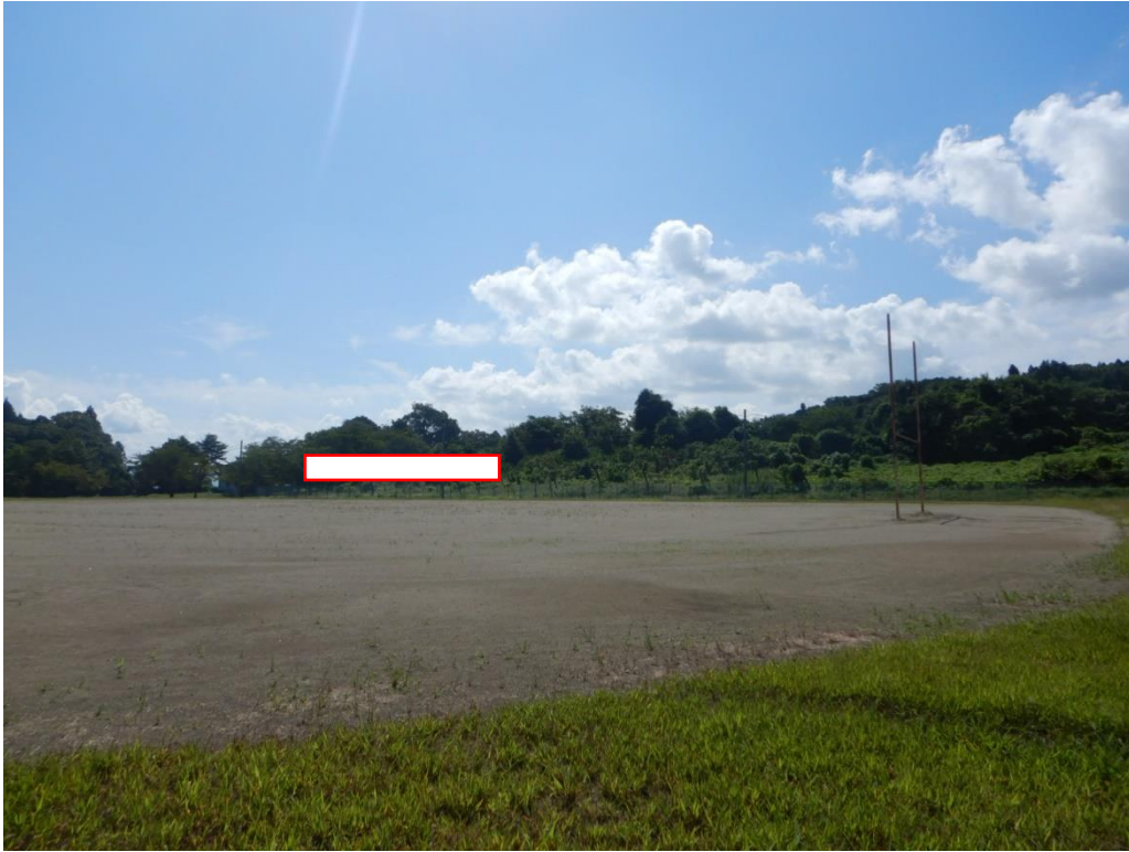
多目的グラウンド②南側外周フェンス付近
