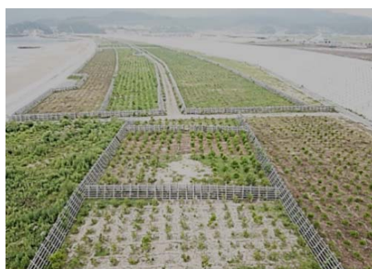
高田松原地区災害復旧工事 防風工
