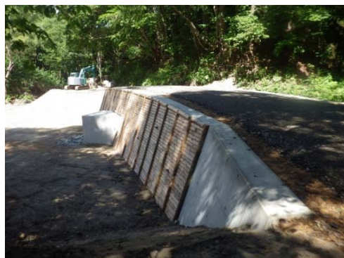
間伐材を使用した「木製型枠パネル（木製残存型枠）」工法（盛岡森林管理署）
