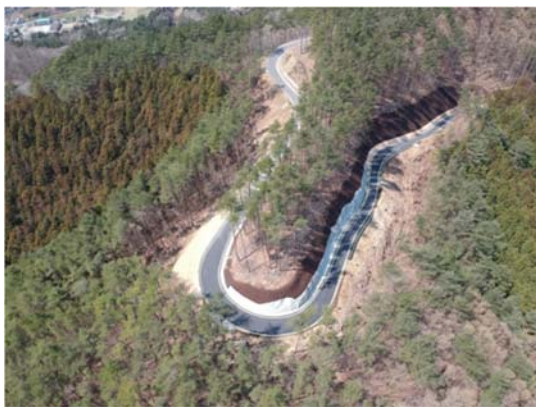
開通した林道の全景
