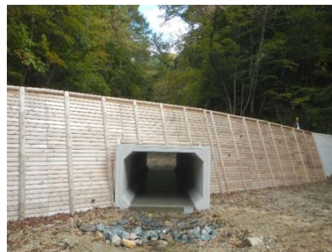
間伐材を使用した「木製型枠パネル（木製残存型枠）」工法（盛岡森林管理署）
