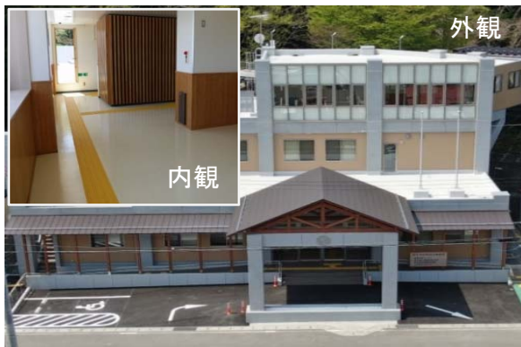
庁舎【内装木質化】(宮古市)
