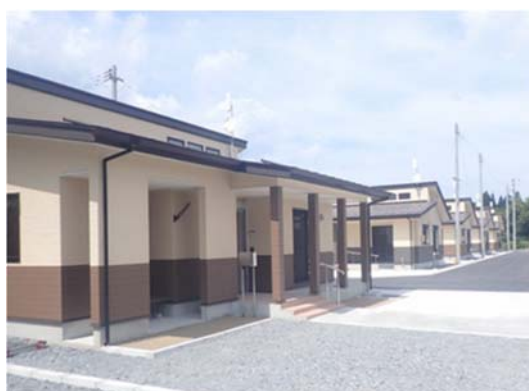
県有施設の木造化（災害公営住宅）
