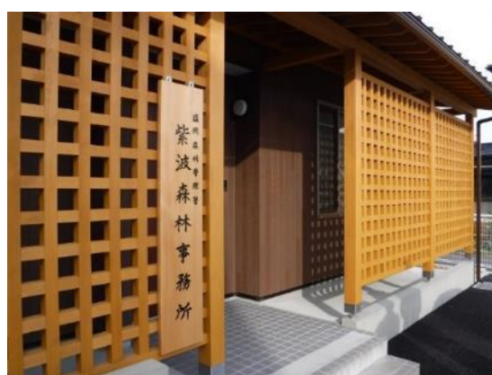
木造新築事務所 (盛岡森林管理署紫波事務所)
