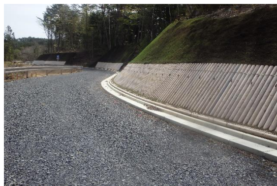
丸太伏工（森林管理道八木玉川線（洋野町））
