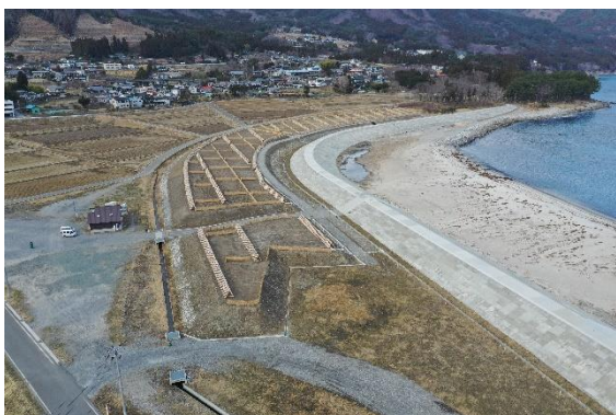
防風工（吉浜地区防災林造成事業（大船渡市））
