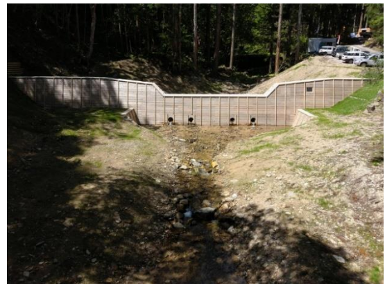
木製残存型杭工法による治山ダム (盛岡森林管理署)
