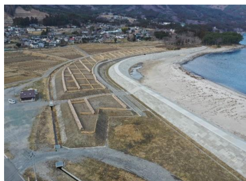
吉浜地区防災林造成事業 防風工(大船渡市)
