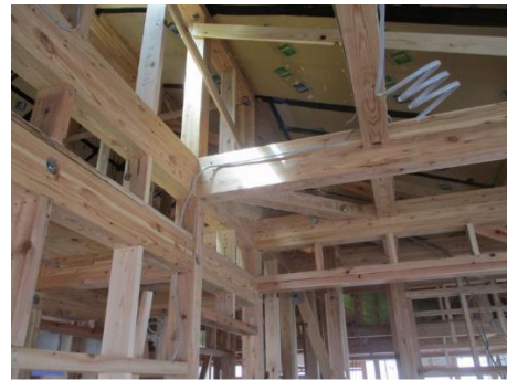
柱、梁などに県産木材をふんだんに使用した住宅
