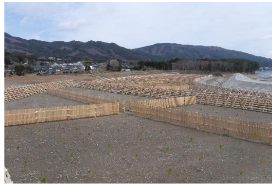
防風工（吉浜地区防災林造成事業（大船渡市））
