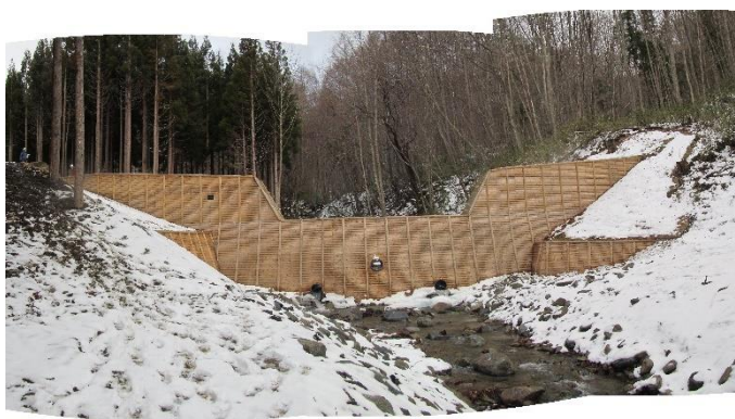
木製パネル式残存型枠（戸塚地区復旧治山事業（宮古市））
