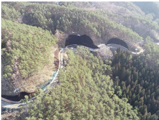
開通した林道の全景
