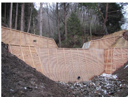
木製パネル式残存型枠（戸塚地区復旧治山事業（宮古市））
