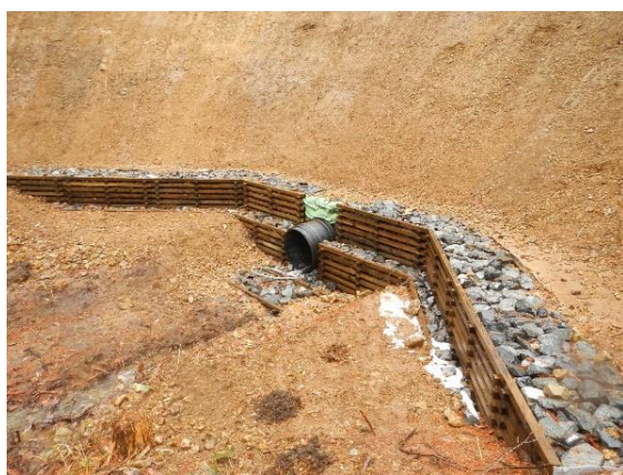
法面を保護する高耐久性木製枠工（盛岡森林管理署）
