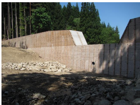
木製パネル式残存型枠（白浜地区復旧治山工事）
